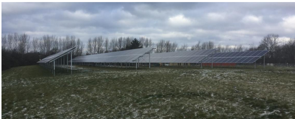
4 Her ses Kalundborg Forsynings 440 solceller ved Ornum Renseanlæg
