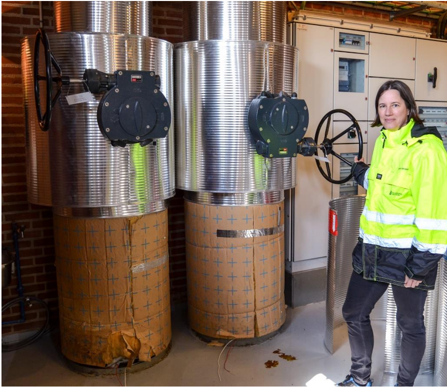
Projektleder Laura Hurni Jensen, Kalundborg Forsyning, drejer håndtaget på ventilen, hvor den grønne hovedledning føres ned i Jorden. Det sker i pumpehuset på Rynkevang. Foto: Kalundborg Forsyning
